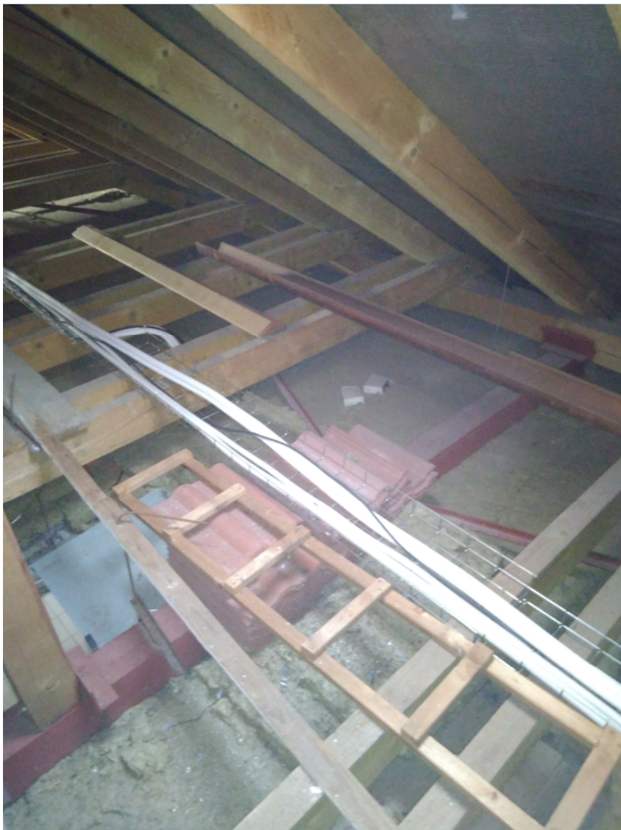
Vestavěná ocelová konstrukce v hlavní vazbě
